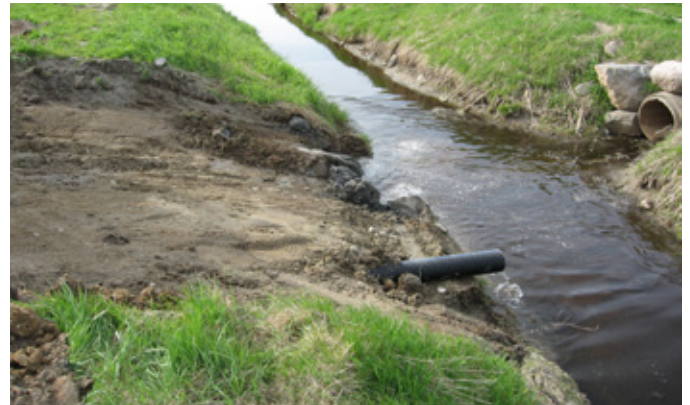
Photo 7 : Shaping a spillway Source : Mikael Guillou (MAPAQ)
