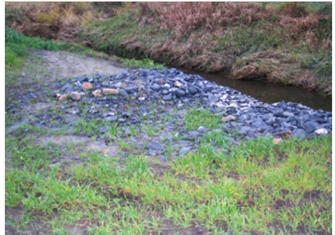
Photo 4 : Inlet apron for rock chute spillway Source : Mikael Guillou (MAPAQ)
