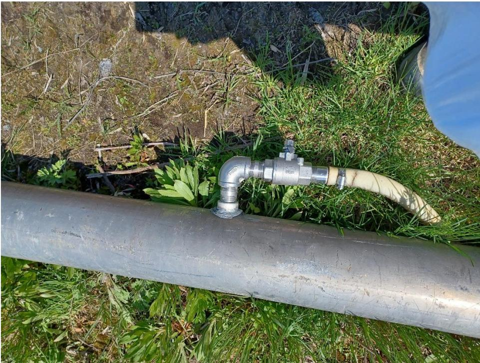
Installation d'une valve sur le tuyau d'irrigation du lisier pour faciliter l'échantillonnage
