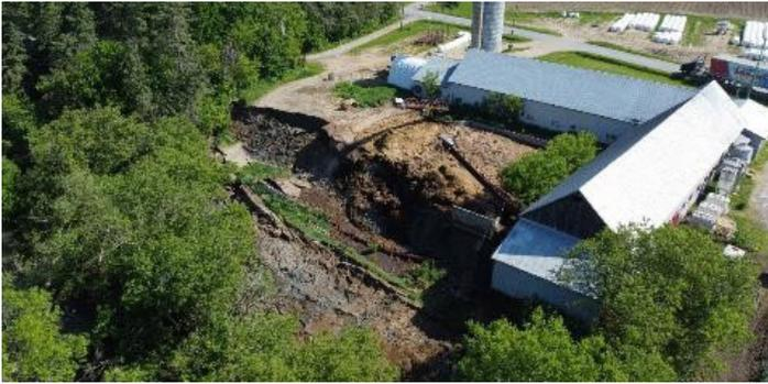
**Figure 3.6** Exemple de glissement de terrain affectant l'intégrité d'un bâtiment agricole. © Ministère des Transports et de la Mobilité durable (MTMD)
