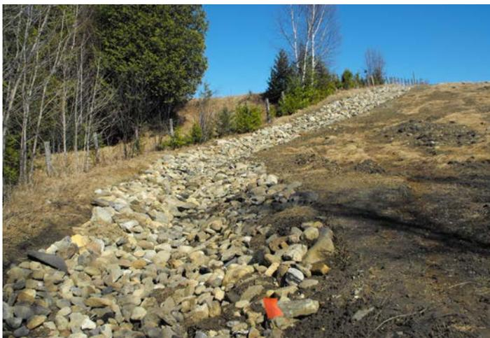
**Figure 3.17** Enrochement de fond de fossé de drainage en pente forte. © Chloé Boucher-Ravenhorst
