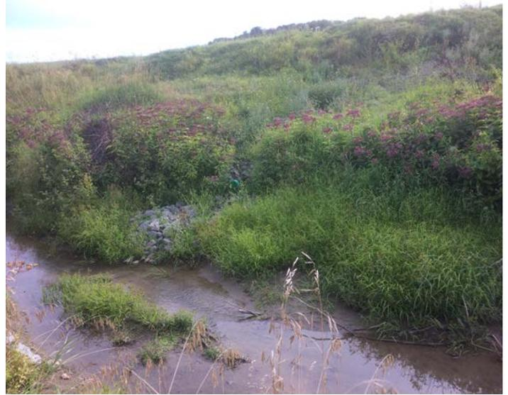
**Figure 3.11** Sortie de drain aménagée et protégée en pied de talus. © MAPAQ Mauricie
