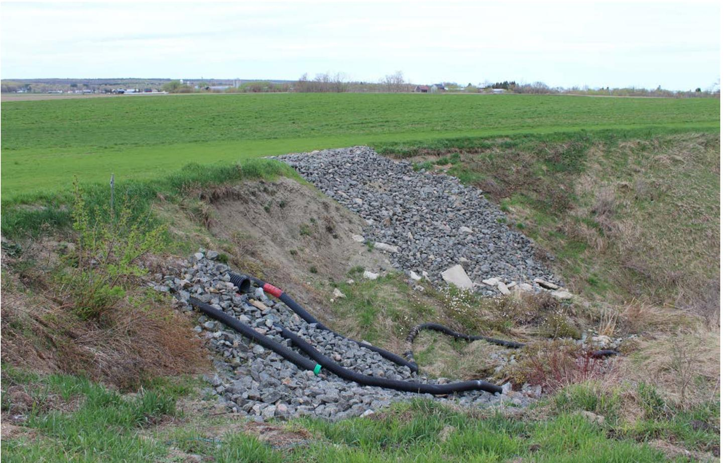
**Figure 3.12** Sorties de drains rallongées jusqu'au pied de talus avec des tuyaux flexibles non perforés. © MAPAQ Mauricie
