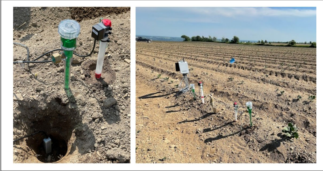
Figure 6. Installation des tensiomètres et des sondes Watermark et FDR sur le site Valupierre en 2021
