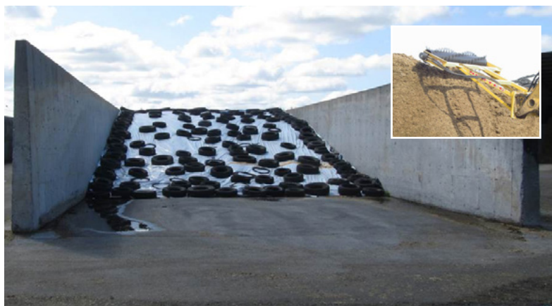
Silo horizontal de type bunker
