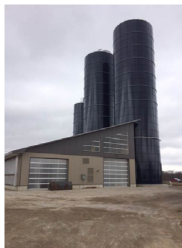
Silo vertical à vidange par le bas
