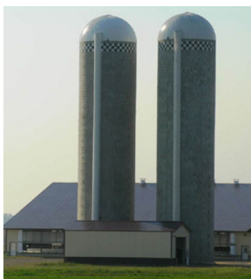
Silo en douves de béton à vidange par le haut
