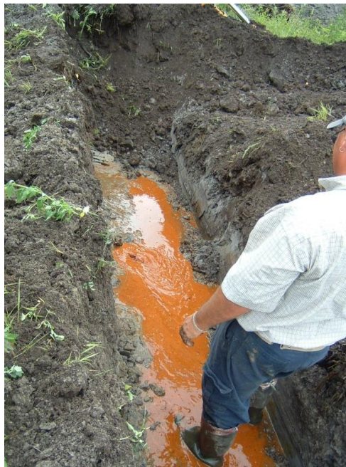
Figure 9 : La couleur de l'eau est une indication évidente d'un problème de colmatage par l'oxyde de fer lorsqu'un drain a été débloqué au niveau du collecteur.
