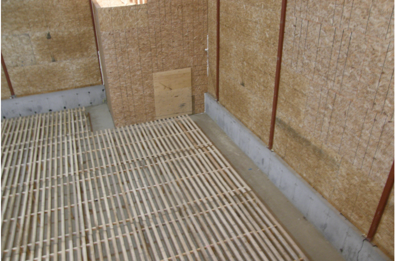
Figure 1: Vue de l'intérieur d'une des deux cellules . On remarque le caillebotis en place et qui couvre toute la surface sauf la périphérie à une distance de 1 m du mur. Les murs au coin de la cellule correspondent à la chûte à foin pour la reprise dont les dimensions sont de 3,5 x 2,5 m.
