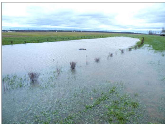
Bassin en fonctionnement lors d'une crue Source : Victor Savoie (MAPAQ)
